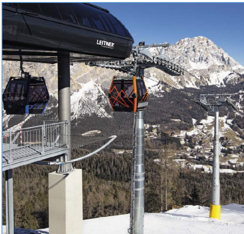
TIPOLOGICO SOSTEGNO DI LINEA CABINOVIA 10 POSTI
