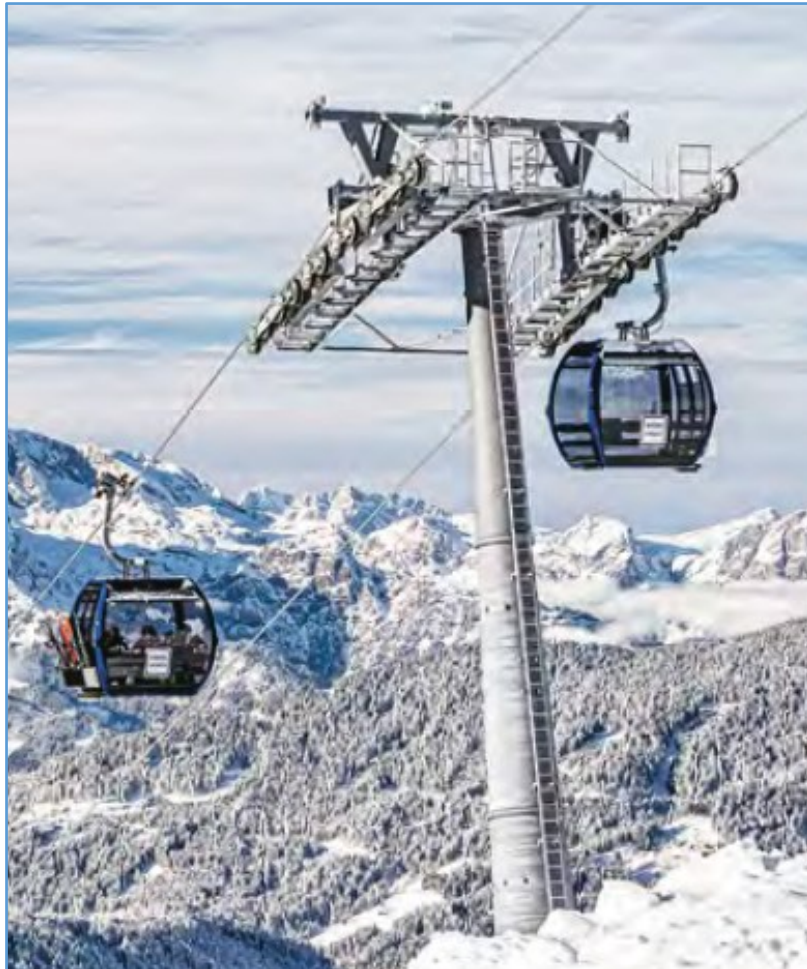
TIPOLOGICO SOSTEGNO DI LINEA CABINOVIA 10 POSTI
